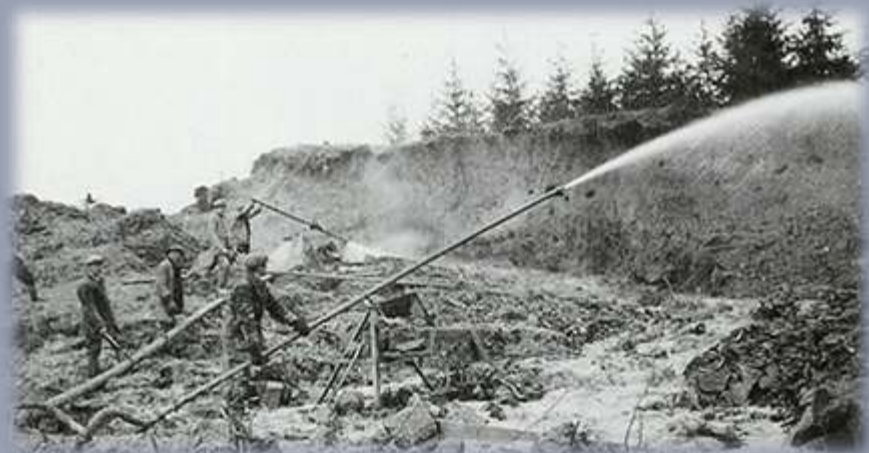
Naplavování zeminy do prostoru Bahňáku
